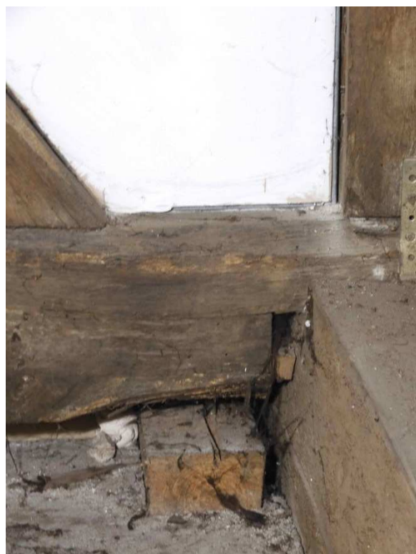
Fot. 12 Oparcie ściany poprzecznej wewnętrznej na podwalinie
