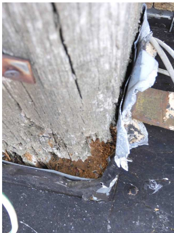
Fot. 8 Taras wieży - zdestruowana podstawa słupa ze zniszczonymi obróbkami blacharskimi
