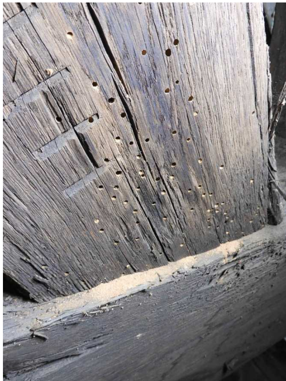
Fot. 13 Ślady aktywności drewnojadów - technicznych szkodników drewna
