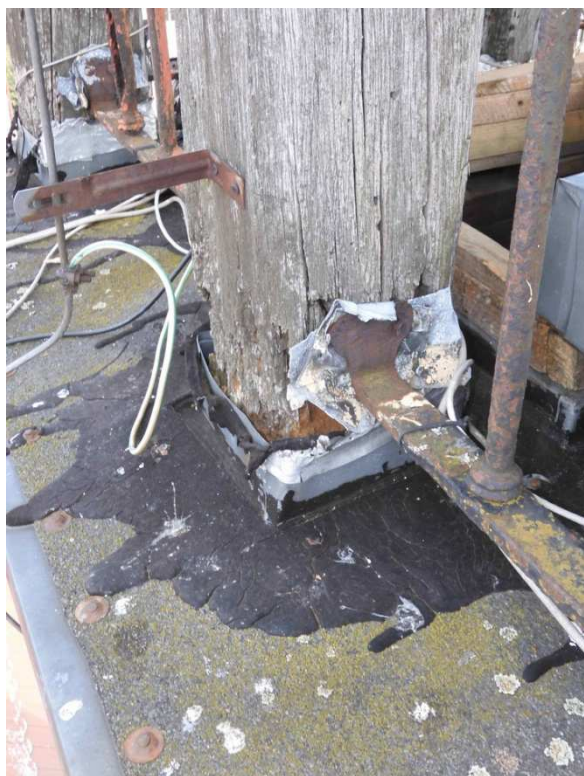
Fot. 7 Taras wieży - zdestruowana podstawa słupa ze zniszczonymi obróbkami blacharskimi
