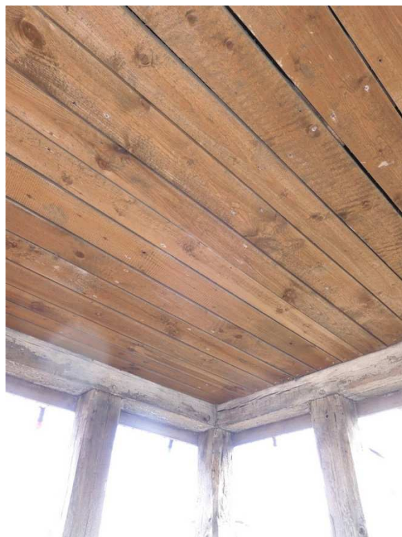
Fot. 10 Deskowanie podniebienia hełmu wieży
