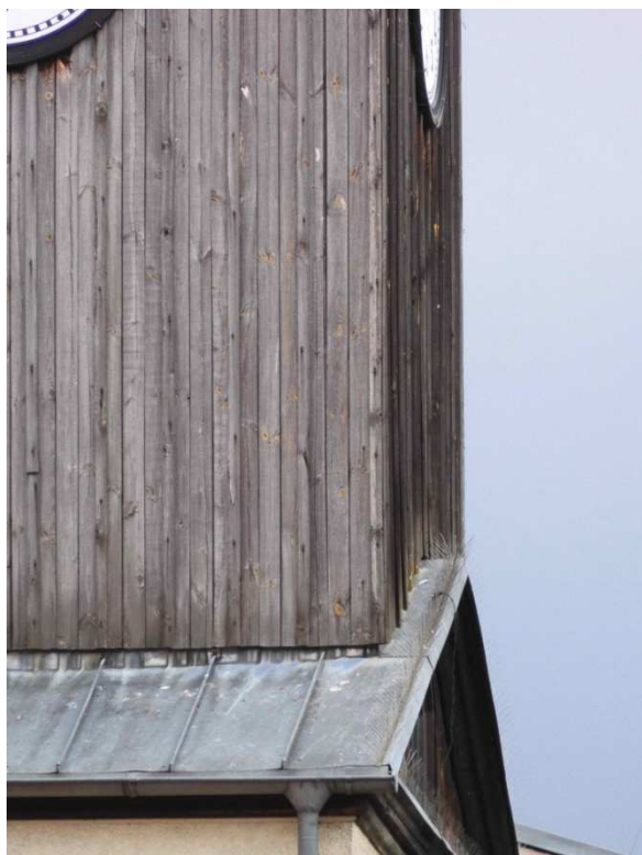
Fot. 5 Elewacja pld.-zach. wieży - deskowanie i pokrycie dachowe podstawy wieży
