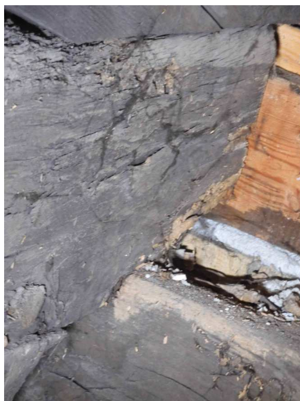
Fot. 16 Podstawa wieży - skorodowane oparcie krokwi połaci pld.-zach. na oczepie
